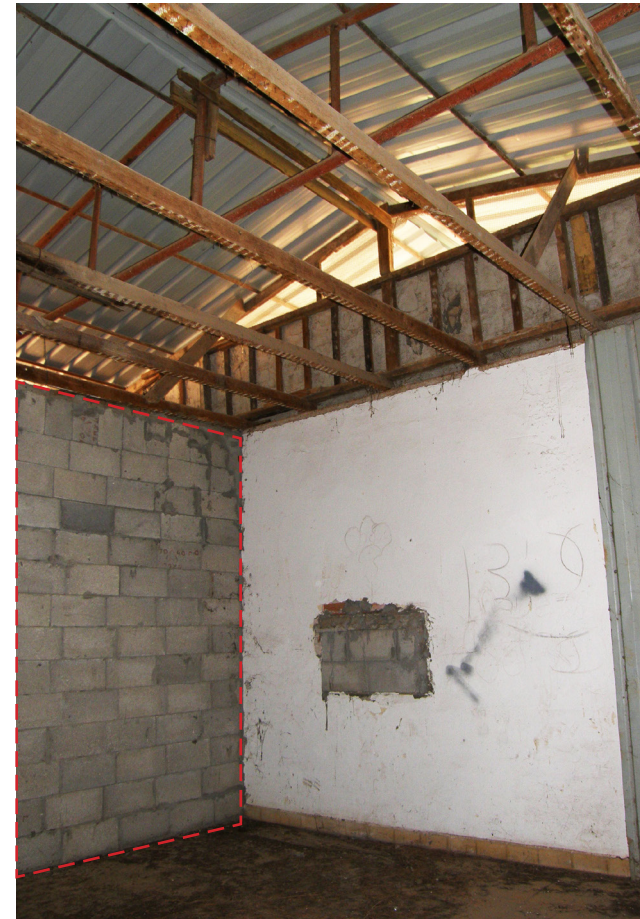
2. מבט לכיוון דרום מערב. ניתן לראות את הקונסטרוקציה של הגג בבירור. מצד שמאל, קיר בלוקים מאוחר
