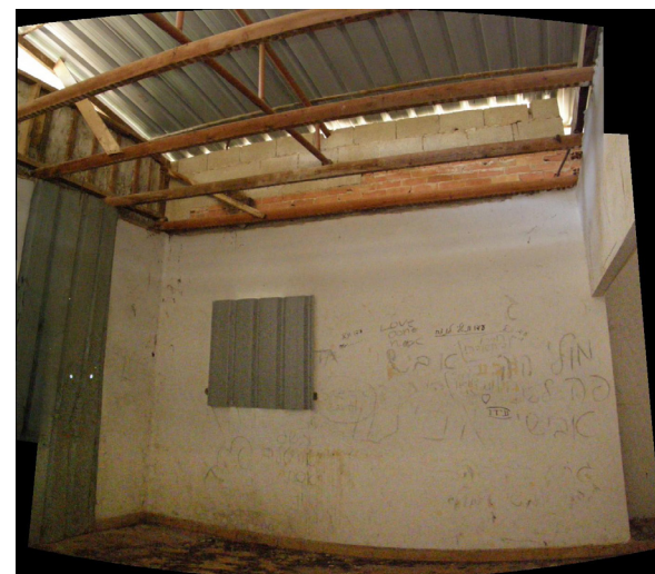
4. מבט לכיוון צפון. בתמונה נראה שקיר הבריקים האדום אינו קיר תומך
